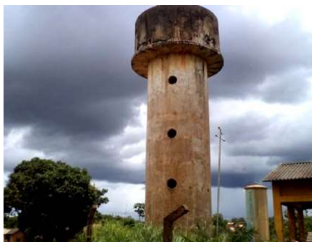
FIGURA 19 FILTROS DE PRESSÃO DA ETA E RESERVATÓRIO ELEVADO DE 100 M 3 E 15 M DE ALTURA
