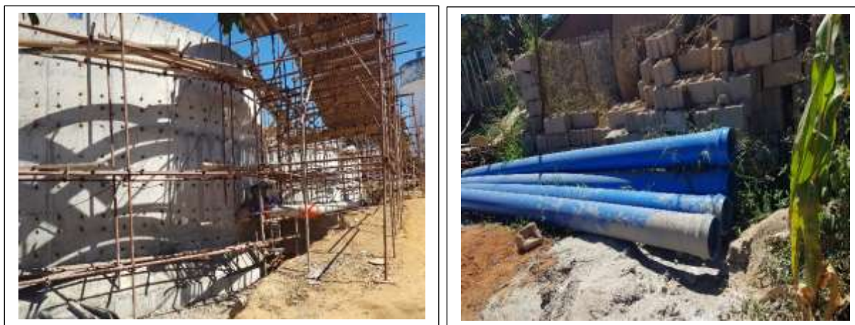
FIGURA 22 TUBAGEM DE SAÍDA DO RESERVATÓRIO E ANTIGO RESERVATÓRIO ELEVADO REABILITADO E TUBAGEM PVC
