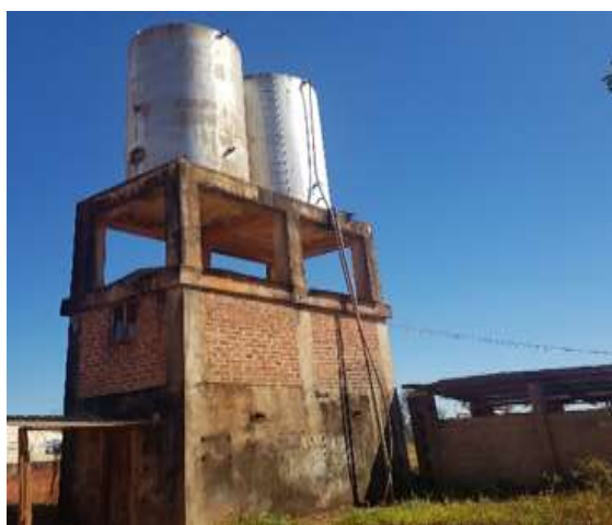
FIGURA 19 FILTROS DE PRESSÃO DA ETA E RESERVATÓRIO ELEVADO DE 100 M 3 E 15 M DE ALTURA
