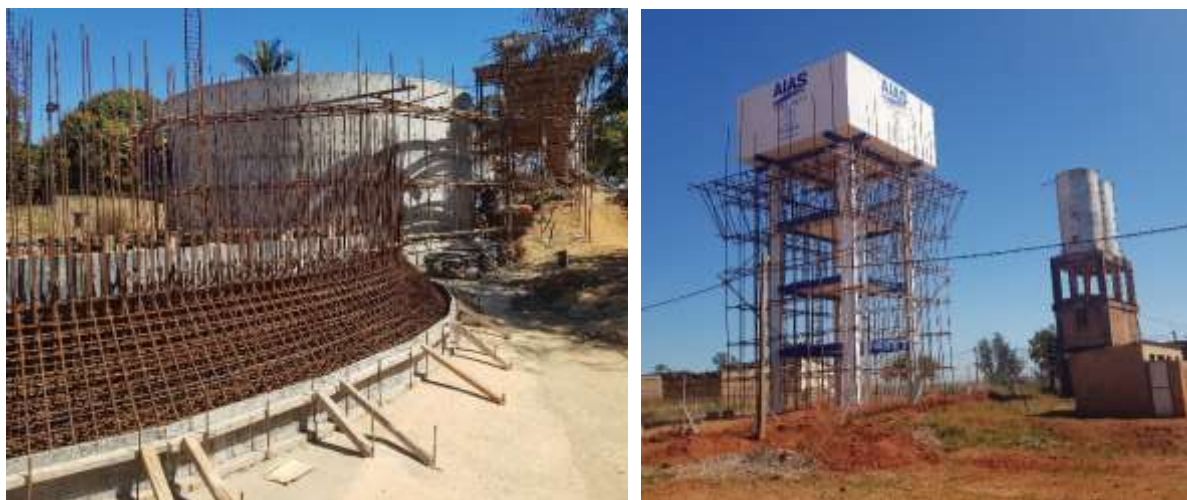
FIGURA 21 RESERVATÓRIOS 500 M3 SEMIENTERRADOS EM CONSTRUÇÃO NO CD1 E RESERVATÓRIO ELEVADO DE 200 M3 EM CONSTRUÇÃO NO CD2
