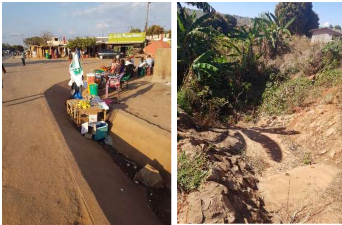
FIGURA 27 VALA DE DRENAGEM EXISTENTE, UTILIZADA PARA VENDA (ESQUERDA) E PASSAGEM MOLHADA EXISTENTE (DIREITA)
